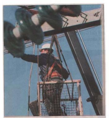
Kletterkünstler: An der Leonhardstanne bauen Heag Südhessische Energie AG (HSE) und GSI eine neue Umspannanlage mit einer Spitzenleistung von 30 Megawatt, um das geplante neue Forschungszentrum mit Strom zu versorgen. Die Fundamente liegen bereits, derzeit feilen HSE-Mitarbeiter an der Verbindung zur schon bestehenden Stromleitung. FOTO: ROMAN GRÖSSER
